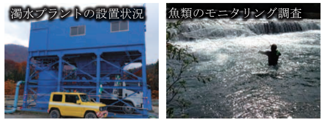
写真-4 環境に関する取り組み状況（水環境）
