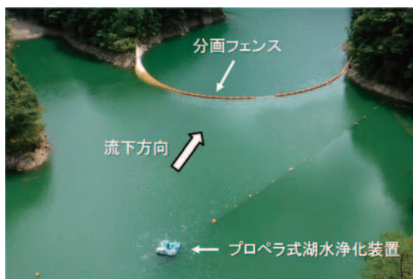
図-10 装置設置状況写真
