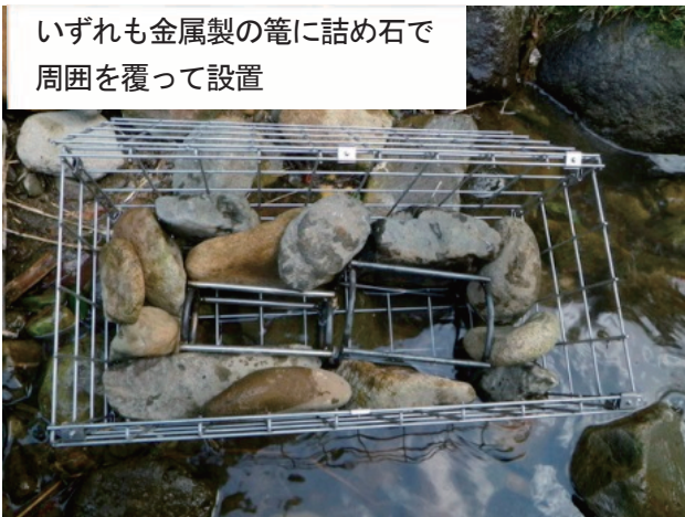
図-8 繁殖場ユニット (上：ユニット外観、下：内部構造)
