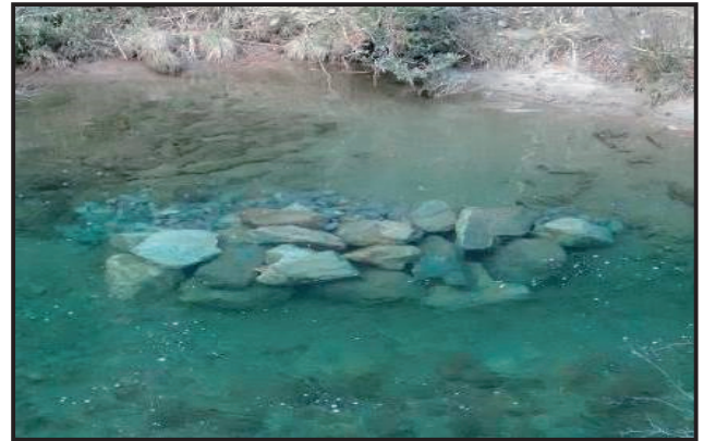
図-6 実験淵に設置した保全対策工の様子
