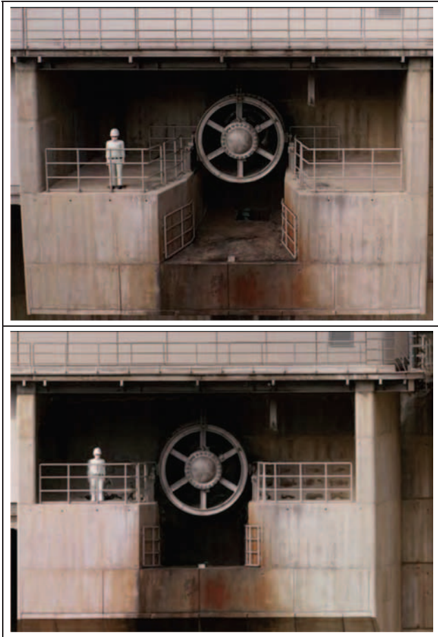
図-7 画像の比較 (上:UAV近接写真、下:合成写真)
