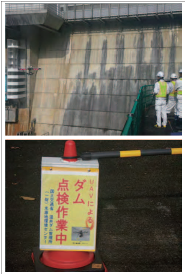
図-3 撮影状況と安全対策
