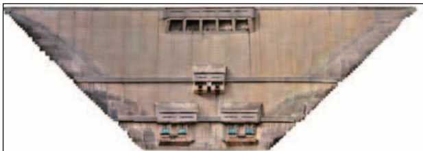
図-4 堤体下流面合成写真
